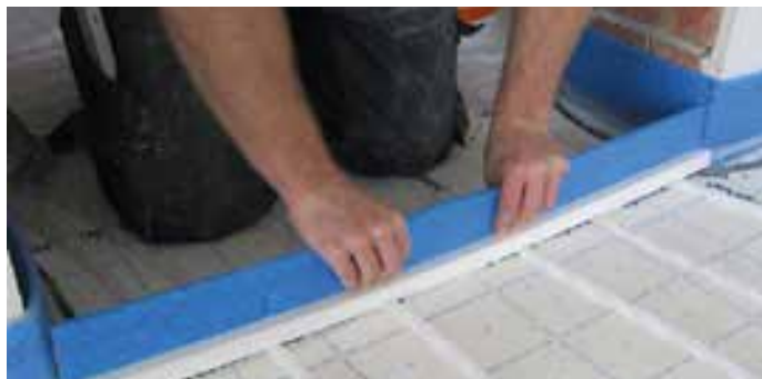
② Druk het T8-Pro profiel op de verwarmingsleidingen
