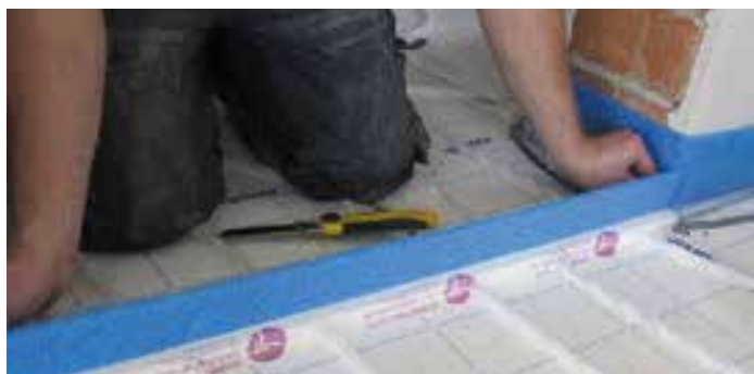
④ Plaats het profiel in positie
