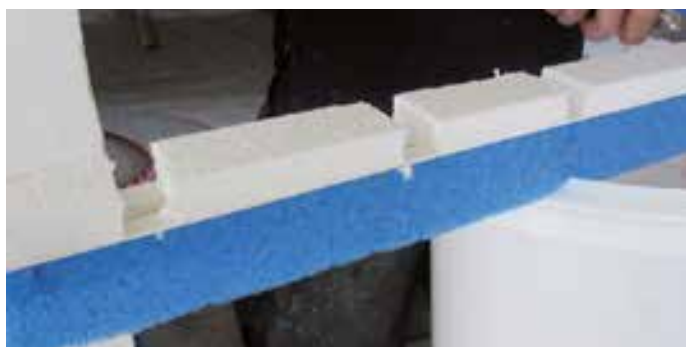
② Druk het T8-Pro profiel op de verwarmingsleidingen
