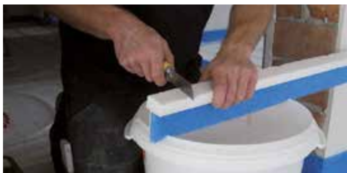
③ Snijd de afdrukken van de leidingen uit het profiel
