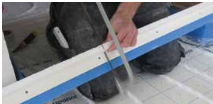
① Eventueel op lengte zagen krimpvoegprofiel (bijvoorbeeld bij deuren)
